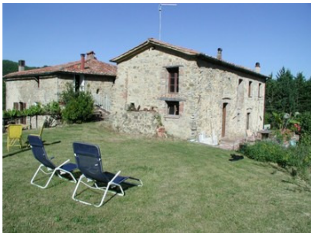
Blick vom ehemaligen Dreschplatz auf das Haupthaus (links) und das Nebenhaus (rechts), das früher eine Scheune war und erst 2002 zur Ferienwohnung ausgebaut wurde.
